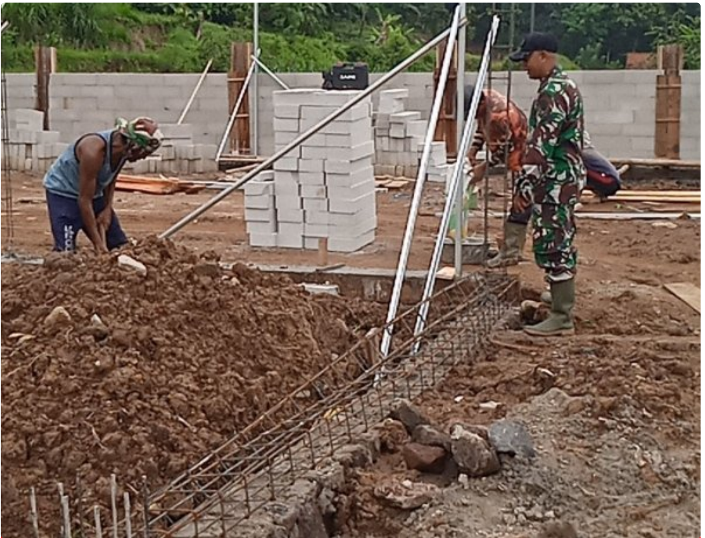
Pembangunan KDKMP Desa Cipicung
